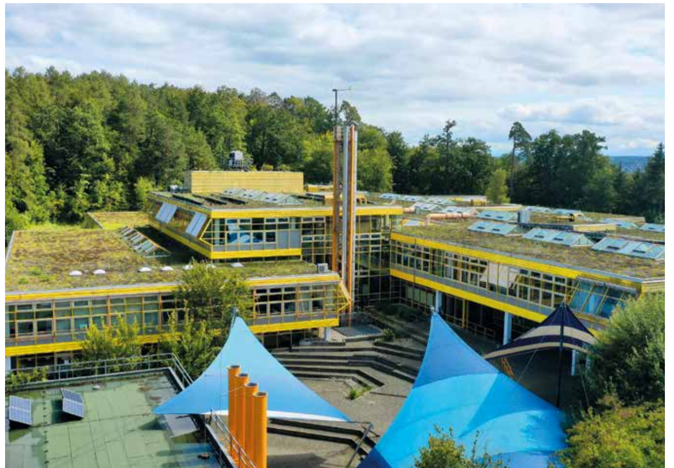
An der Geschwister-Scholl-Schule wurden 2.700 m 2 Dachfläche saniert. Auch 2021 liegt ein Schwerpunkt der Klimaschutzbemühungen weiterhin auf der energetischen Sanierung der städtischen Gebäude sowie dem Ausbau erneuerbarer Energien.
