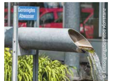
Gereinigtes Abwasser aus der Konstanzer Kläranlage
