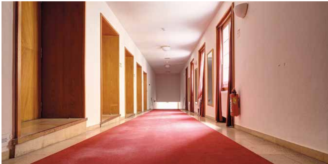
Brandschutztüren und eine Fluchttreppe für den Rang: Das neue Brandschutzkonzept macht Umbaumaßnahmen in den Räumlichkeiten des Theaters Konstanz notwendig.
