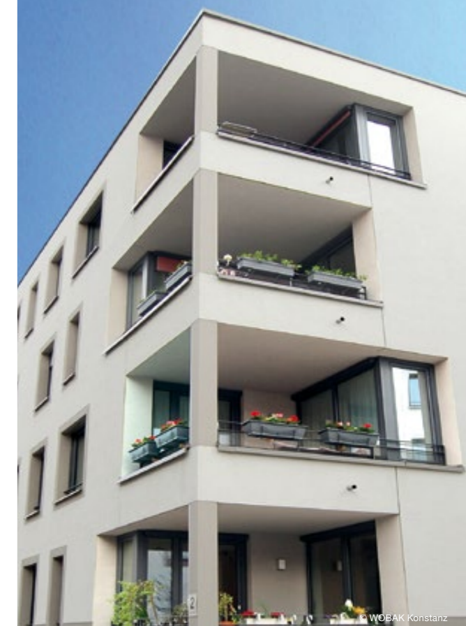
Balkone an der Bruder-Klaus-Straße
